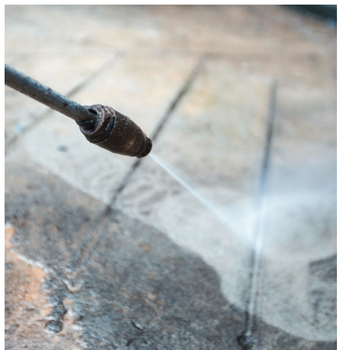
CEDRAL Faserzement-Terrassen lassen sich mit einem Hochdruckreiniger gemäß Anleitung reinigen.
